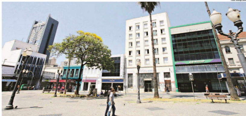
Um dos projetos já protocolados prevê a reabilitação de um prédio localizado na região do Largo do Rosário (foto); a Prefeitura divulgou apenas informações preliminares até o momento, mas ele está desocupado e passará por troca de elevadores e das redes elétricas e hidráulicas, entre outras modificações
