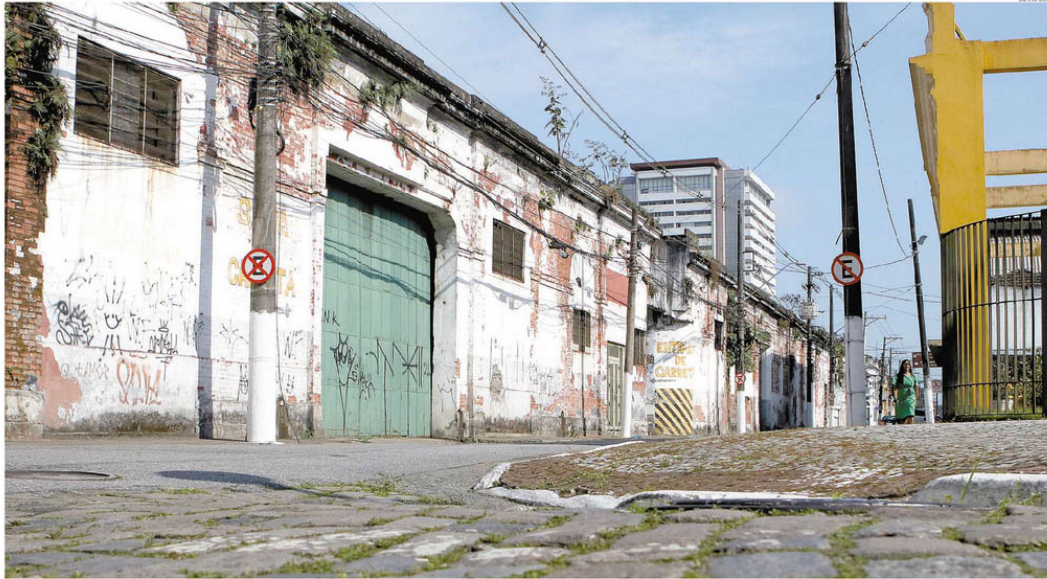
O trecho da Rua da Constituição entre as ruas General Câmara e Xavier da Silveira ganhará cara nova. Ali, deve ser construído um calçamento interligado ao Outeiro de Santa Catarina, marco da fundação de Santos
