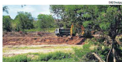
Obras de transposição de esgoto do Rio Bauru; imagem é de 2021
