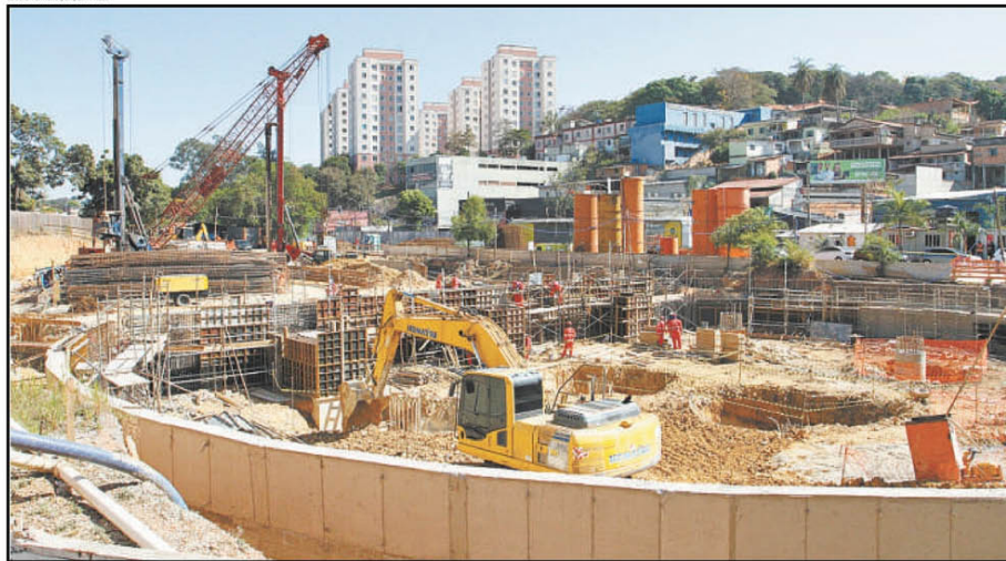
Obra na Avenida Vilarinho é parte do programa para evitar enchentes e inundações na capital, que começa a ser concluído em 2024
