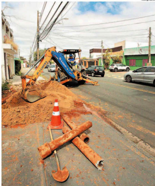
A Sanasa também está substituindo 450 quilômetros de rede de água, para reduzir o volume de perdas, cujo índice está bem abaixo da média nacional
