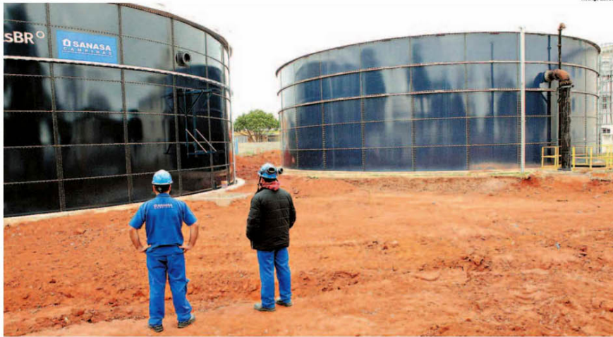
Entre as obras em andamento estão 20 novos reservatórios de água, que aumentarão em 38,02% a capacidade de armazenamento da cidade
