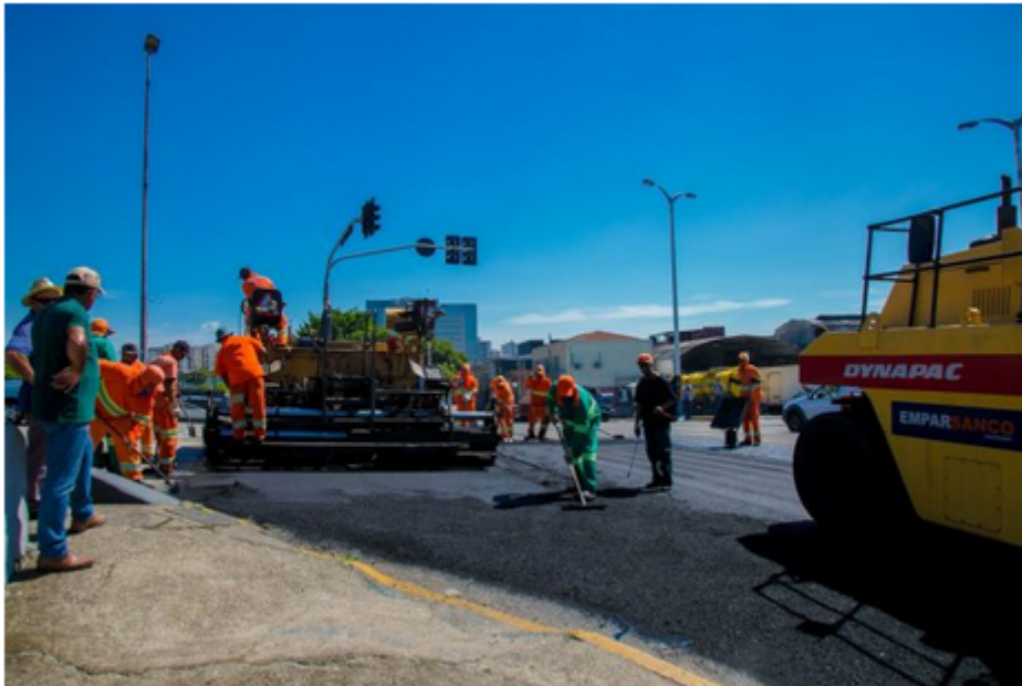
Obras de tapa-buracos é um dos serviços que a prefeitura executa durante do Governo em Movimento- Fotos Letícia Teixeira / PMSCS
