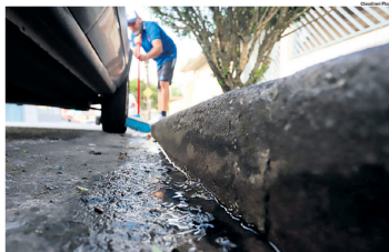
QUEIXAS. Vazamentos como este, em Mauá, e falta de reparo nas ruas estão entre principais reclamações
