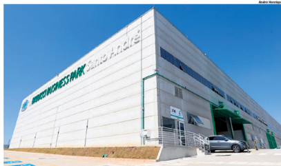
ESTRUTURA. Centro logístico foi responsável pela criação de 1.000 empregos durante a construção
