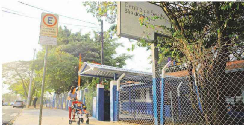
O Centro de Saúde do bairro São Domingos, na região sul de Campinas, ficou sem energia elétrica durante parte da manhã de ontem devido ao apagão nacional; fornecimento de energia foi restabelecido às 9h
