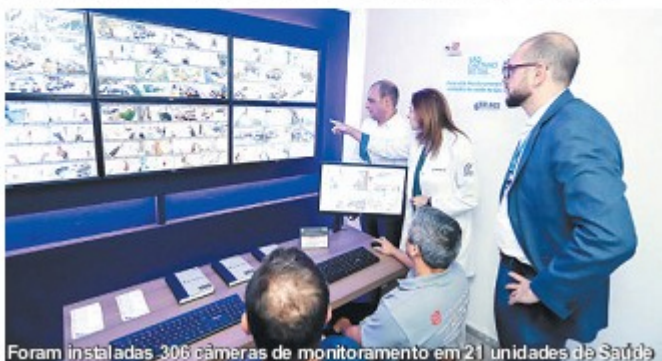
Foram instaladas 306 câmeras de monitoramento em 21 unidades de Saúde
