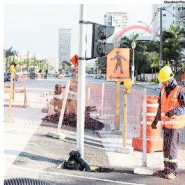
OBRA. Construção do BRT-ABC avança para Av Lauro Gomes
