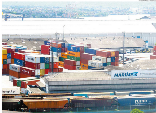
Na área hoje ocupada pela Marimex, na região de Outerinhos, será construída a pera ferroviária que agilizará operações no porto santista
