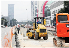
BRT-ABC. Obra herdada da gestão anterior está em execução
