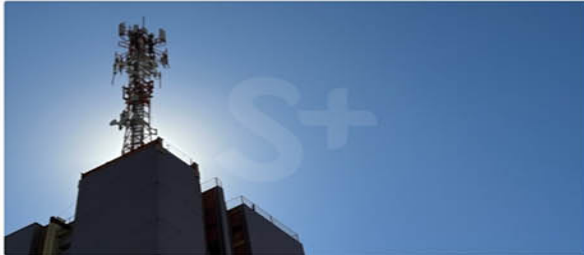
Edifício de empresa de telefonia em Adamantina. (foto: Siga Mais)
