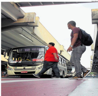
ESTAÇÃO. Usuários reclamam da proteção parcial do espaço, além de demora para saída dos coletivos
