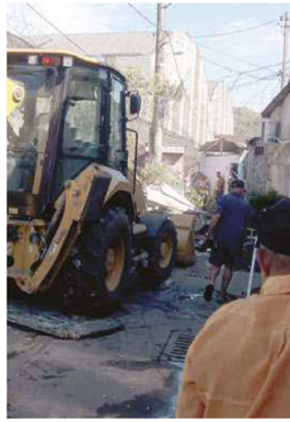
Duas casas e pequenos comércios foram demolidos na Alemoa
