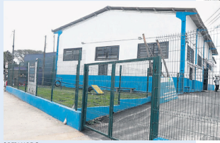
S. BERNARDO. Aporte da obra foi de R$ 1,5 mi, mais R$ 4 mi para gear equipamento
