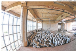
A construção abandonada desde 2013 tem 7 mil metros quadrados
