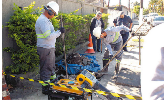
O anúncio ocorreu durante apresentação do trabalho de busca de vazamentos, com a utilização de equipamentos como o geofonamento
