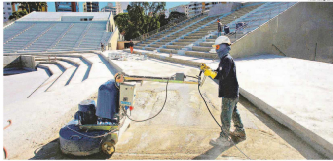
A reforma do Centro de Convivência Cultural é uma das 127 ações registradas no Mapa Digital de Obras; intervenção integra o PAES, programa que em dois anos gerou 15 mil empregos e movimentou R$ 1 bilhão em investimento do município
