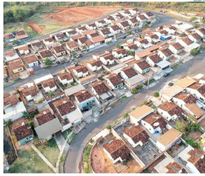
Conjunto habitacional em Pompeia (SP): antigo Casa Verde e Amarela, programa recuperou nome original
