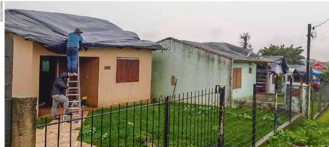
Em Vera Cruz, telas tiveram de ser colocadas em telhados danificados
