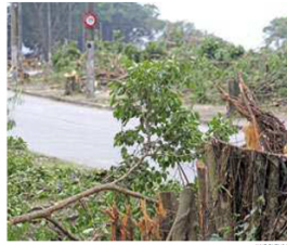
Derrubada faz parte de obra de urbanização da Vila dos Pescadores
