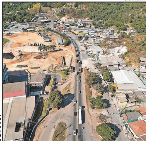
Vista aérea da BR-381, próximo da ponte sobre o Rio das Velhas: concessão vai durar 30 anos, com arrecadação estimada em R$ 25,73 bilhões no período
