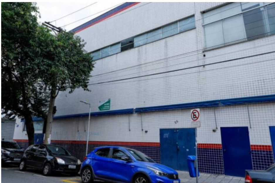
Equipamento será instalado na esquina das ruas Manoel Coelho e Conde Francisco Matarazzo, no Centro - Foto: Eric Romero / PMSCS
