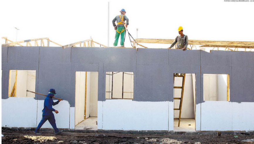
Objetivo é construir moradias direcionadas para pessoas que vivem em áreas de risco, como encostas, morros e regiões alagáveis. Serão 6 mil residências na Baixada Santista
