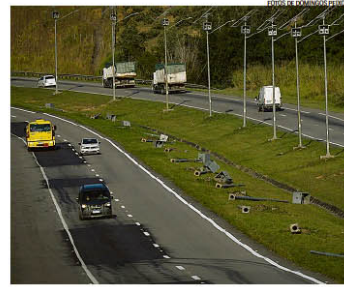
Espaço para melhoria. Postes de iluminação solar derrubados em rodovia
