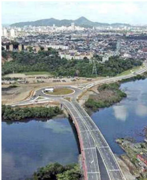
Terreno onde será construído o Conjunto Santos "AB" Prainha II, localizado em Santos, conta com 63 mil metros quadrados
