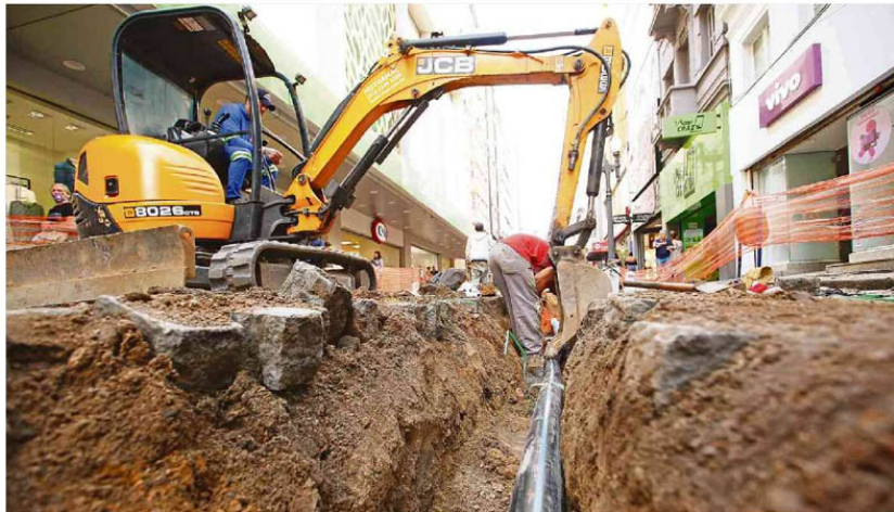
Obras de substituição de materiais na Rua dos Andradas, no Centro Histórico de Porto Alegre
