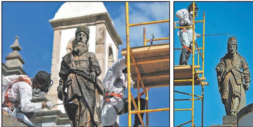
Equipe de restauração aplica produto de limpeza nos estátuas dos profetas Naum e Amós durante os trabalhos de ontem, que começaram pelas peças que ficam no plano mais elevado e extremidades do adro
