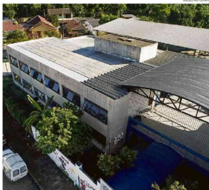
Na Visconde do Rio Grande, reparos feitos em telhado
