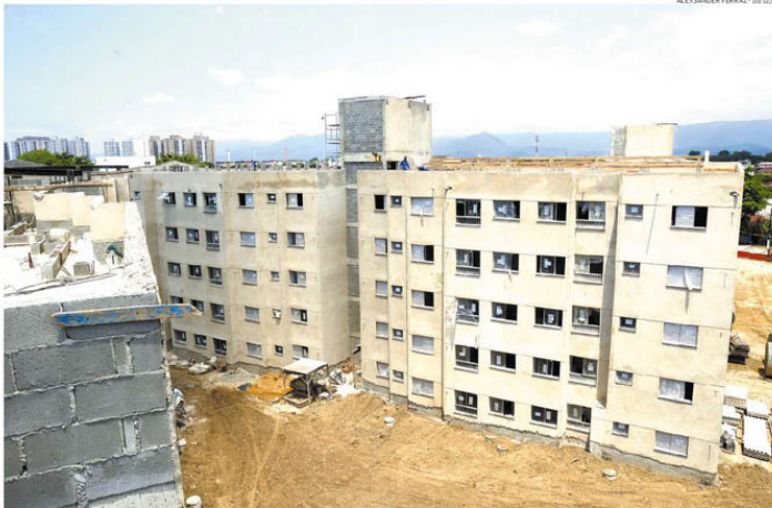
Estão sendo erguidas 1,1 mil residências em Santos, com apoio da CDHU, do Governo Estadual. Delas, 140 atenderão o Bairro Caneleira (foto)
