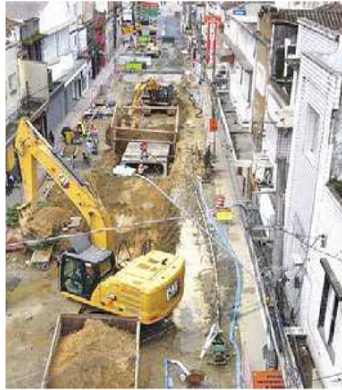
Trecho da Campos Melo passou por obras nesta semana
