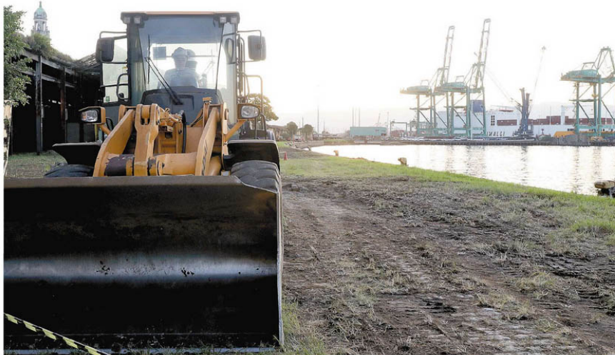
O espaço dos antigos armazéns do Porto de Santos na região do Valongo já conta com retroscavadeiras para a limpeza de toda a área; audiência pública será realizada no dia 31
