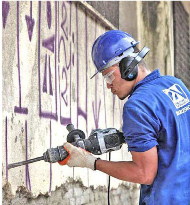
Obras do Mercado não estão afetando e não deverão afetar os mais vulneráveis, que precisam do Bom Prato que funciona no equipamento
