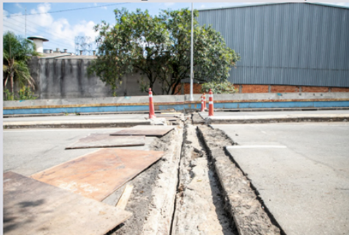
res substituídos. VIADUTO INDEPENDÊNCIA
