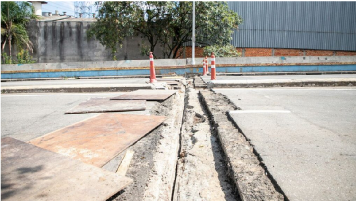
Obras do Novo Viaduto Independência avançam em São Caetano – Foto: Letícia Teixeira / PMSCS
