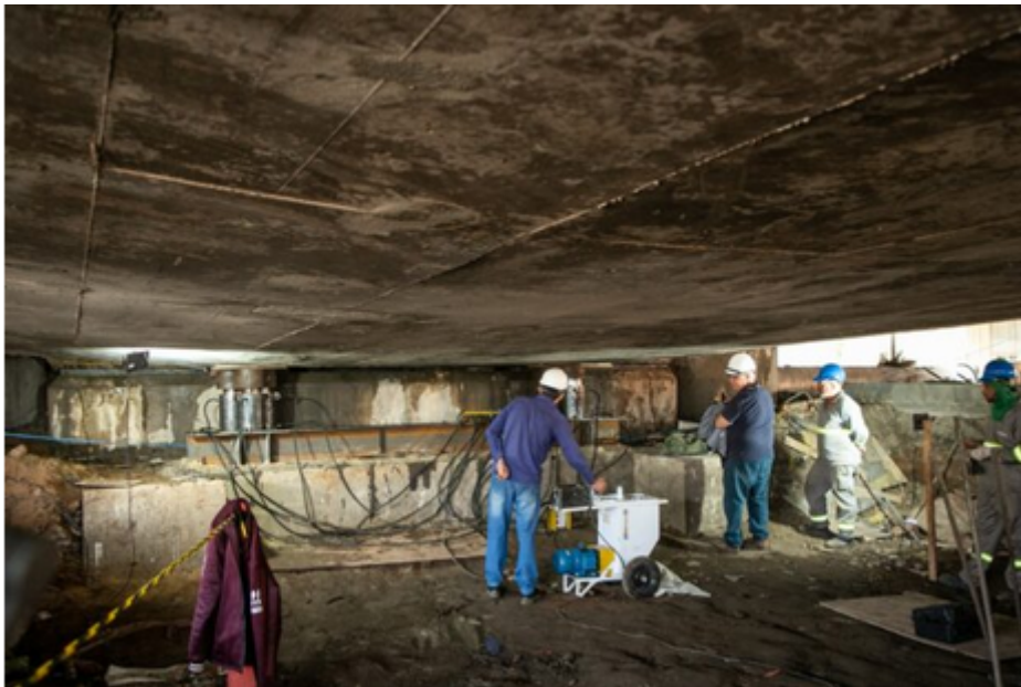
Obras no Viaduto Independência avançam - Foto: Letícia Teixeira / PMSCS
