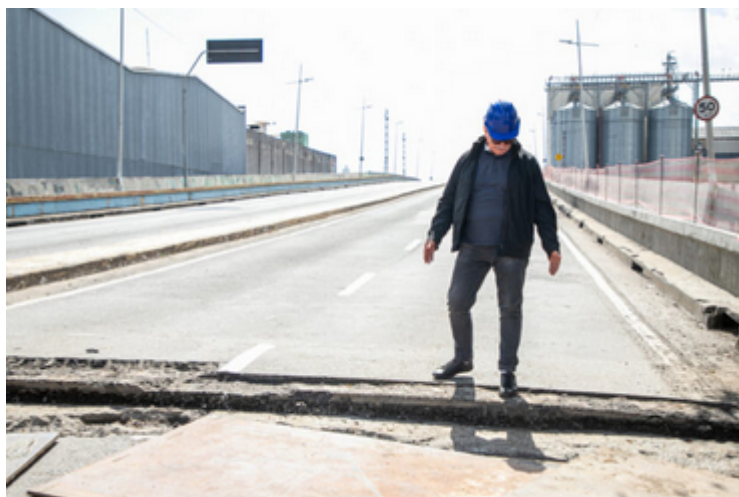
Obras do Novo Viaduto Independência avançam em São Caetano. Foto: Divulgação/PSCS
