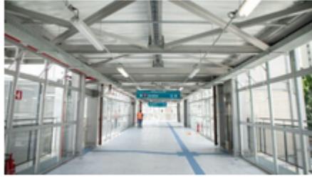
Estação São Caetano da CPTM é modernizada e ganha acessibilidade – Foto: Letícia Teixeira / PMSCS
