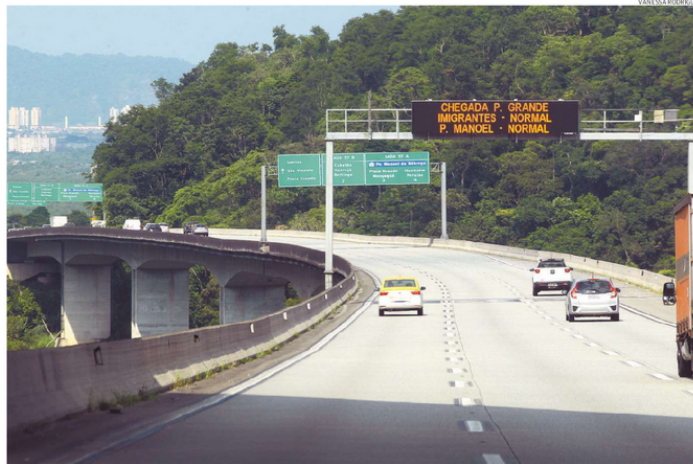
Construção de uma nova rodovia que ligue a Capital à Baixada Santista servirá para desafogar o tráfego e facilitar o transporte de cargas
