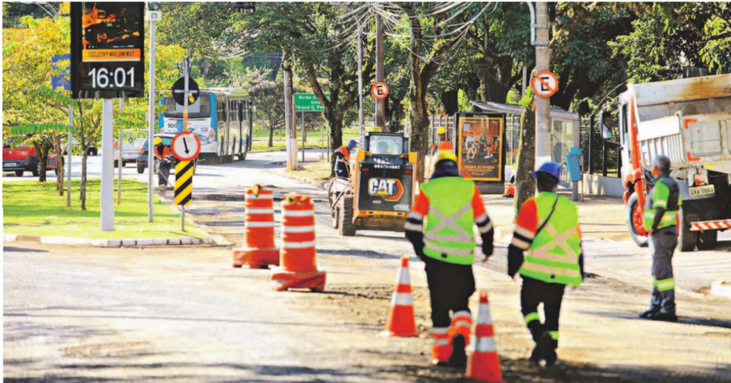
As obras de recapeamento de 70 quilômetros de vias de Campinas tiveram início ontem; as primeiras contempladas pelos trabalhos foram as avenidas Brasil e Barão de Itapura, ambas na região central da cidade
