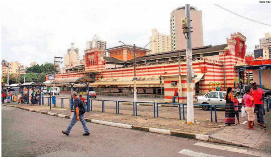
Permissonários vão ficar no estacionamento próximo ao terminal de ônibus em uma estrutura de tendas, como se fosse um grande barracão de lonas, inclusive com tratamento térmico
