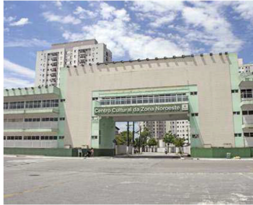
A Defesa Civil apontou a necessidade de intervenções preventivas no bloco central, mas que não há risco
