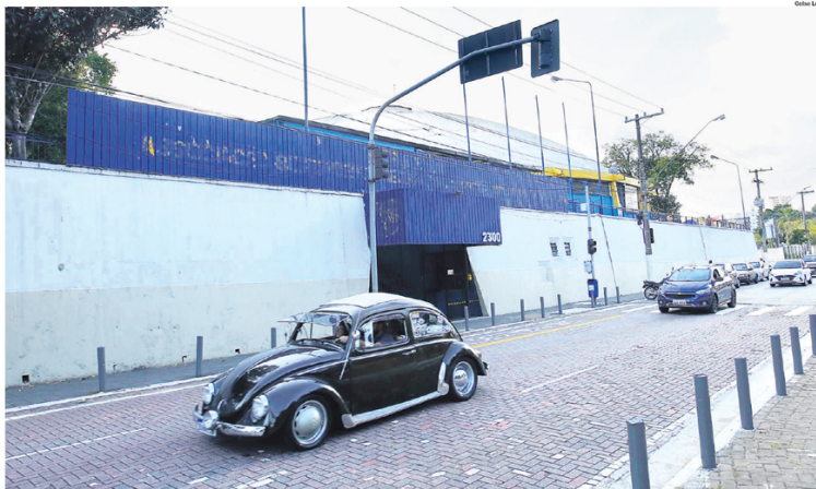
POLÊMICA Segundo associados, instalações do clube da Abrev no bairro Barcelona já começaram a ser demolidas por determinação da Prefeitura para dar lugar a um parque linear
