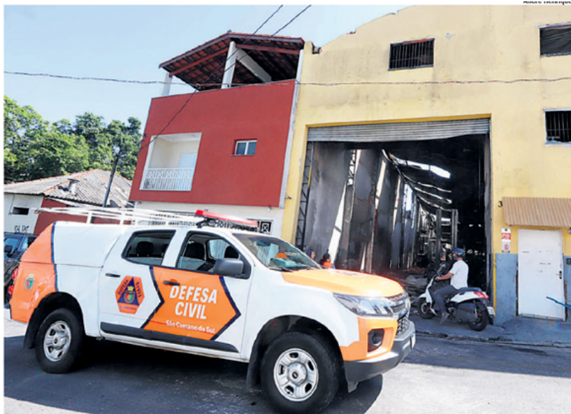
ACÇÃO. Após incêndio destruir local, funcionários começaram a demolir espaço comprometido pelas chamas
