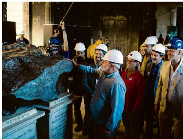
Lula visita obras de reconstrução do Museu Nacional em dia de várias agendas no Rio Eduardo Anzelli/Folhapress
