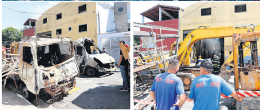
DESTRUIÇÃO. Prédio tem risco de desabamento; veículos queimados foram colocados na rua
