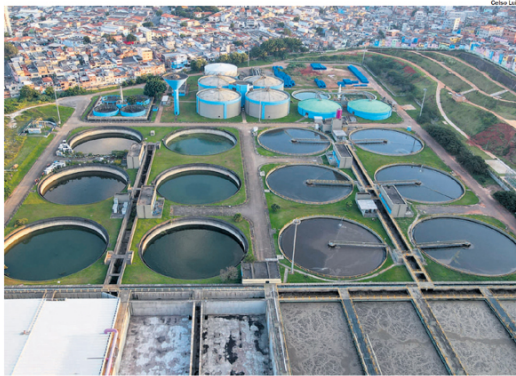
ETE ABC. Uma das estações de tratamento de esgoto da Sabesp que atende os municípios da região
