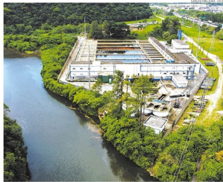
Por abrigar uma Estação de Tratamento de Água, Cubatão tem acompanhado o processo de privatização
